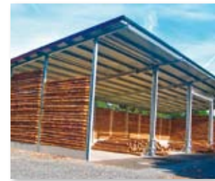
Heizzentrale im Gewerbegebiet; Zwischenlager für Holz aus dem Stadtwald
