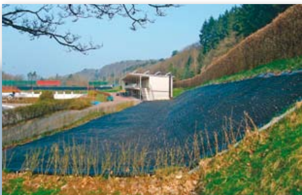
Großes Absorberfeld im Freibad Mettlach
