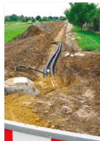
Bau der Wärmeleitung
