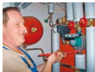
Einbau einer drehzahlgeregelten Heizungspumpe
