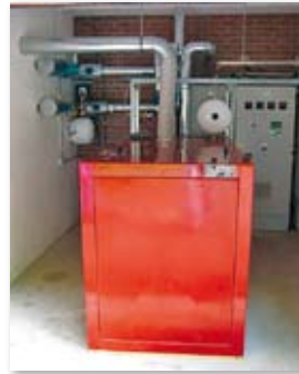
Das kompakte Klärgas-BHKW
