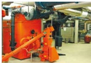
Wildpoldsried – die Energiezentrale der Dorfheizung
