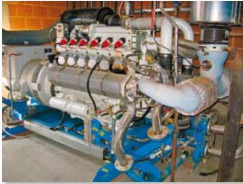
Der BHKW-Motor in der Biogasanlage
