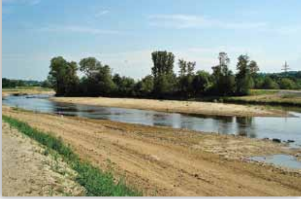
Verlegung der Schussen
