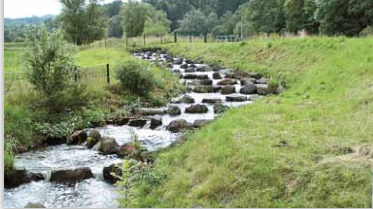
Fischtreppe am Wehr der Firma Reno di medici
