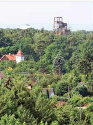
Wald-Hochhaus in der Waldstation Eilenriede
