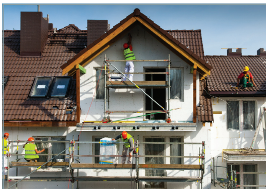
Für die Zukunft – energetische Gebäudesanierung erzeugt positive Wertschöpfungs- und Beschäftigungseffekte.
