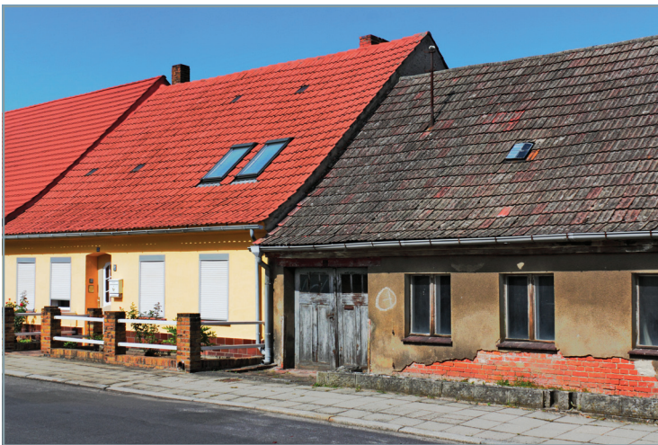
Energieeffiziente Wohnungen dürfen nicht zum Luxusgut werden.
