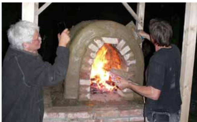
Ein Wunsch ging in Erfüllung: Der Lehmofen bereichert den Garten in Hannover.
